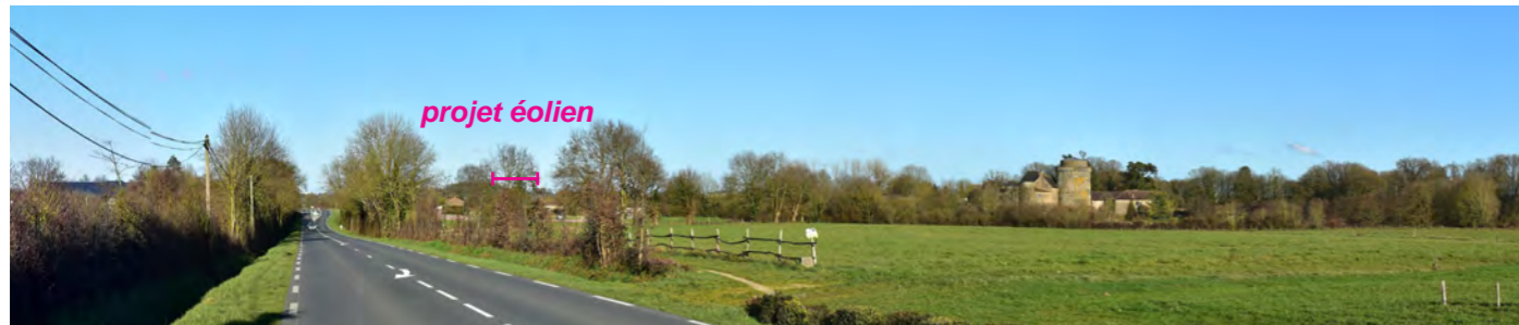
Photographie 151 : Depuis la D960b à l'est de St-Mesmin, le projet est difficilement perceptible, filtré par la végétation.
